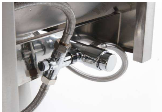
Regulator stopnia mieszania wody cieplej i zimnej pod przyciskiem kolanowym.
