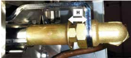
Die Position der regulierenden Muffe
