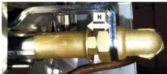
Posición del manguito de regulación
