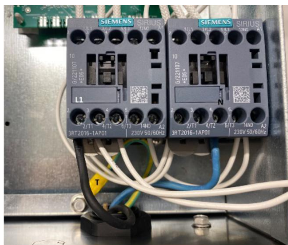
Rysunek 5. Połączenie jednofazowe 230V L+N
