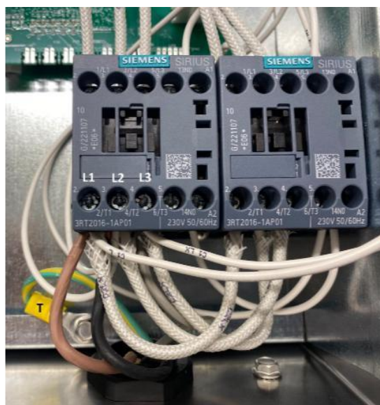
Rysunek 4. Podłączenie trójfazowe 230V 3L
