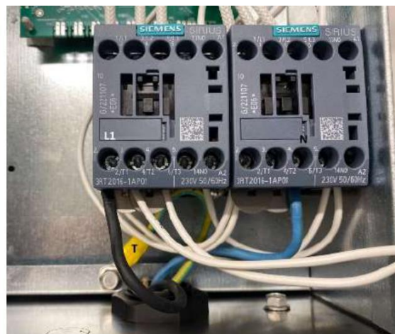
Rysunek 5. Podłączenie jednofazowe 230V 3L
