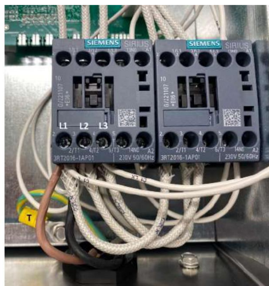
Rysunek 4. Podłączenie trójfazowe 230V 3L
